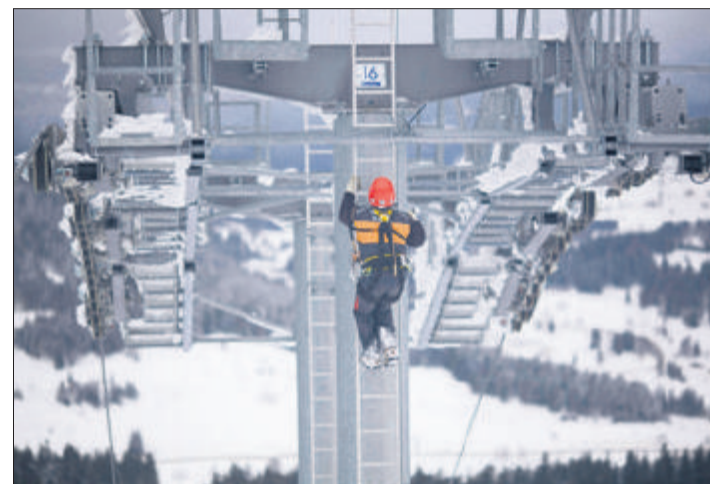
Entre ciel et terre , Joël Cretin brave le vent pour briser la glace souvent présente sur les pylônes du téléski et sur le câble. En été, la révision de l'installation occupe trois personnes durant plus d'un mois.
